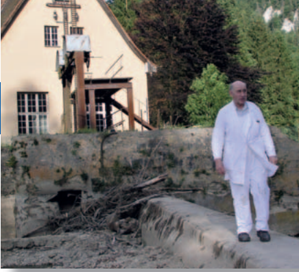
Bruder Wolfgang Keller bei der Inspektion der Baustelle.
